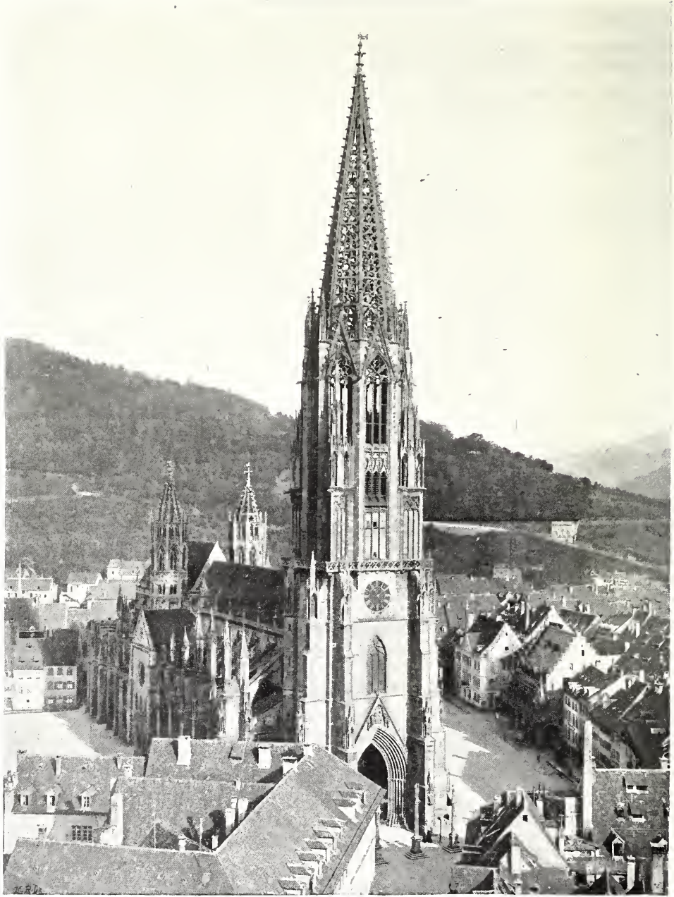
Westansicht des Münsters (vom Thurme der Martinskirche gesehen).
